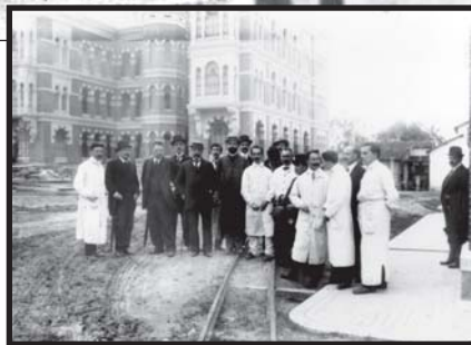
Cientistas em frente às obras do Castelo. No chão, os trilhos através dos quais os materiais de construção eram trazidos do cais.
